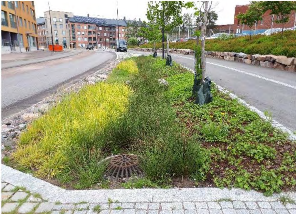
Helsingin kuninkaantammen biosuodatusrakenteet . Kuva: Ramboll
